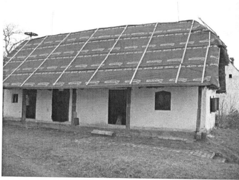
Tájház felújítás előtt
