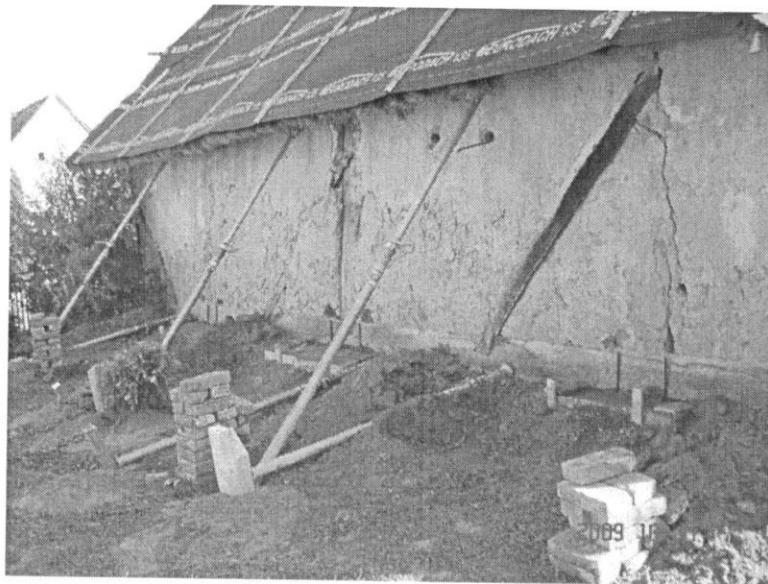
Szerkezet megerősítés munkálatai
