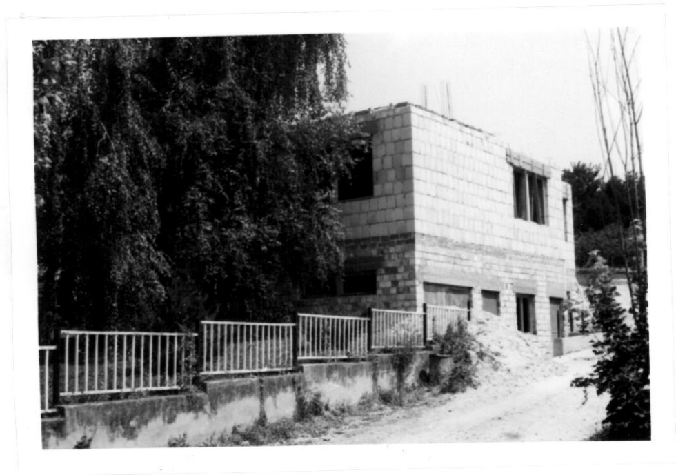
AZ ÉPÜLŐ PÁRTBIZOTTSÁG ÉPÜLETE
